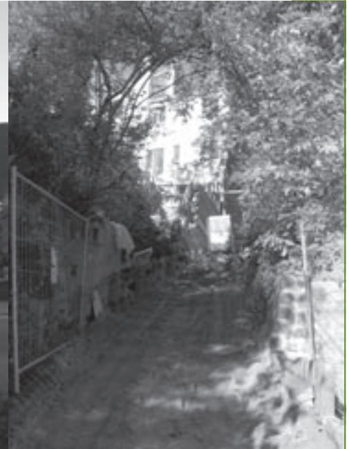
De restauratie van de kerktrap is volop bezig.
